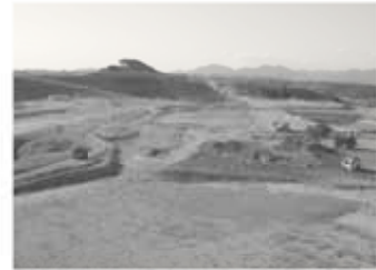
平成20年度の開港を目指して工事が進む静岡空港
